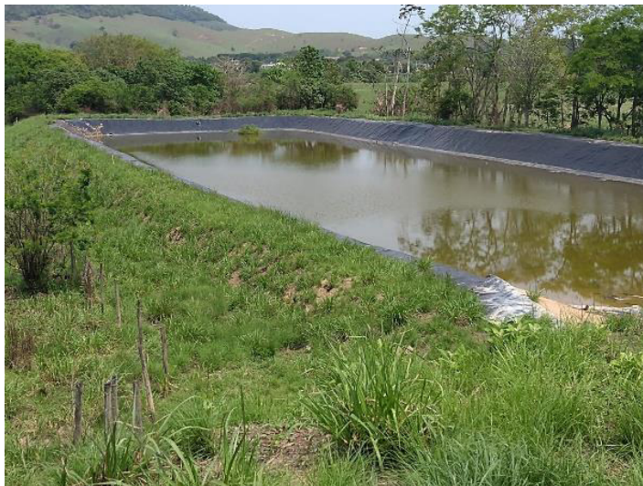
Figura 2 - Aterro sanitário inacabado no município de Tanguá/RJ
