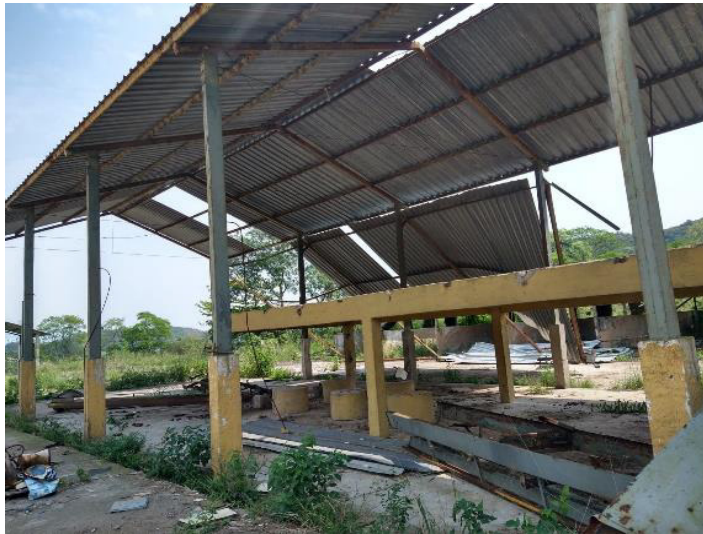
Figura 1- Usina de reciclagem no município de Tanguá/RJ que está desativada
