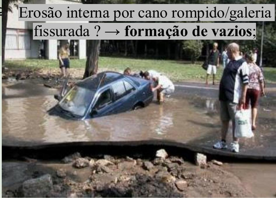
Pavimento perde apoio e **colapsa** sob carga veicular;
