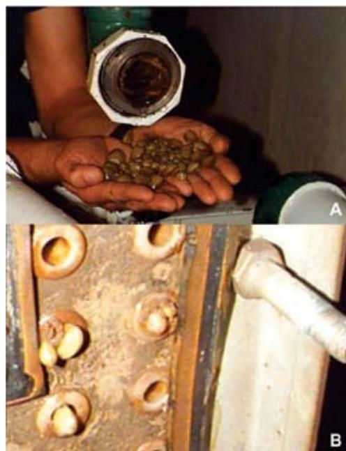
Figura 7. Registro da obstrução pelo berbigão asiático *Corbicula fluminea* (Müller, 1774), na UHE Porto Colômbia, bacia do Rio Grande, alto Rio Paraná, MG, em 1998. 7A, em encanamentos; 7B, em trocadores de calor (Foto: E.T Monteiro da Silva - FURNAS).
